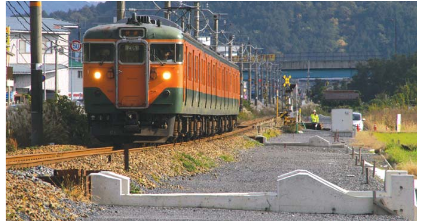
JR山陰本線の複線化工事(平成21年春の完成に向けて工事が進められている)
