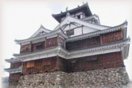
▲福知山城天守閣の石垣には多くの石造物が用いられています。
