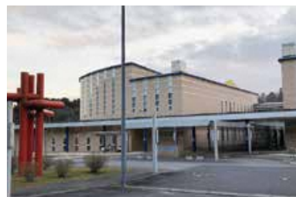
改修工事を行う日吉生涯学習センター
