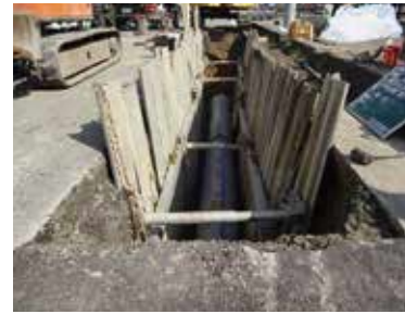
計画的に進む水道管耐震化工事
