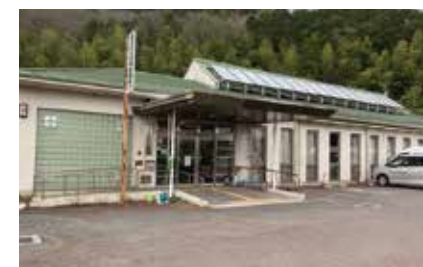
修繕工事を行う福祉施設
