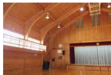
改修工事を行う美山小学校体育館
