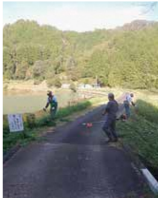
ため池堤体の草刈り作業
