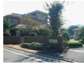
南丹浄化センター
