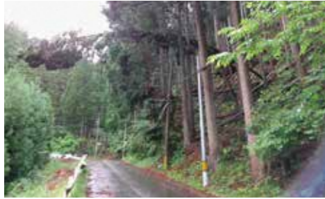
雪害による危険木
