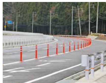
▲一般国道372号南八田道路
