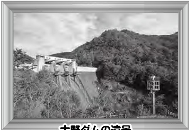
大野ダムの遠景
