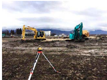
稲わらの除去の様子 (東日本台風等)
