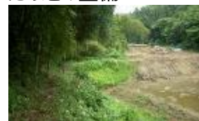
改修前の堤体
