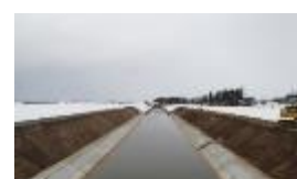
排水路の改修
