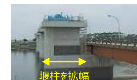
耐震化後の頭首工堰柱
