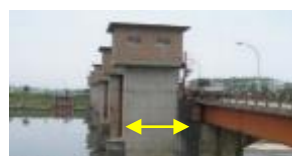
耐震化前の頭首工堰柱
