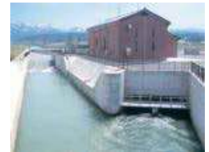
農業用水を利用した小水力発電施設
