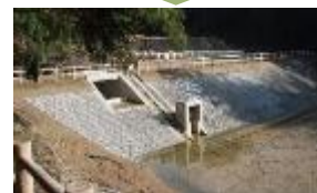
改修後の堤体
