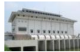
排水機場の改修
