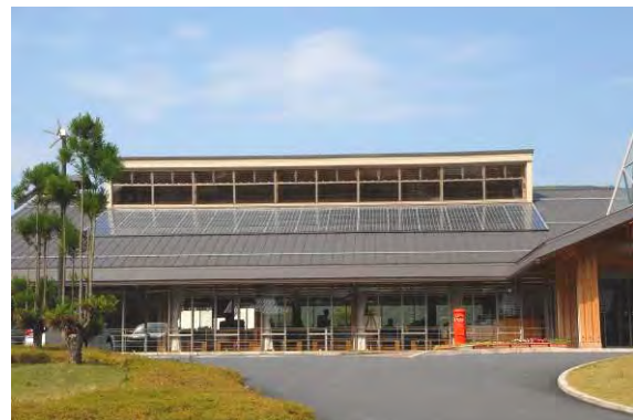
太陽光発電システム （南丹市役所美山支所）
