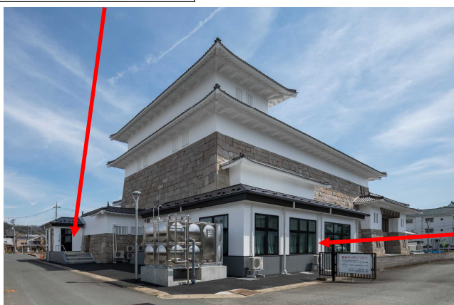
増築部分（東側）
